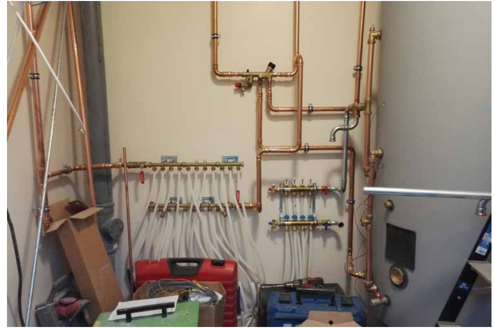
Lämmitysjärjestelmänä on vesi-ilmalämpöpumppu, joka lämmittää lattiat ja käyttöveden. Lämpö saatiin päälle toukokuussa.
